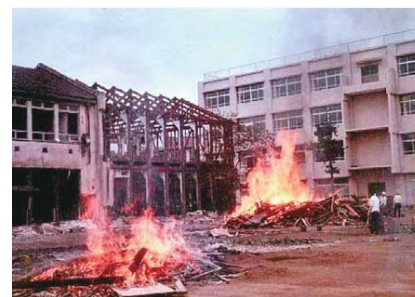
旧校舎解体と新旧校舎
